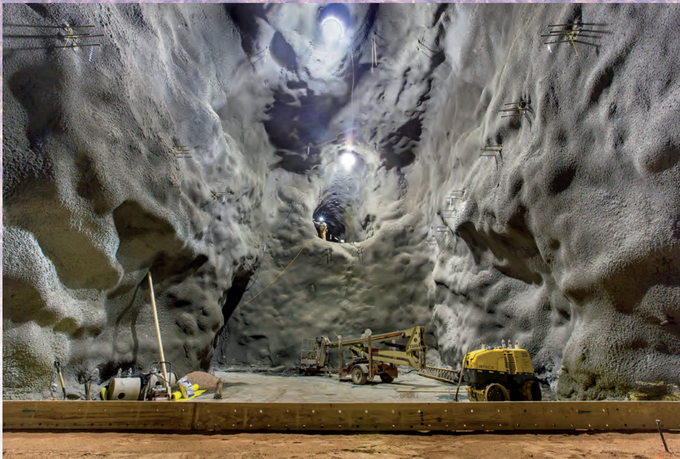
▲ Пещера Дэвиса на 4850-м уровне Сэнфордской подземной исследовательской лаборатории (Sanford Underground Research Facility) уже служила «помещением» для эксперимента нобелевского лауреата Рэя Дэвиса (Ray Davis) по регистрации солнечных нейтрино. В настоящее время пещеру расширили, укрепили стены распыляемым бетоном и приспособили для эксперимента Large Underground Xenon (LUX).
